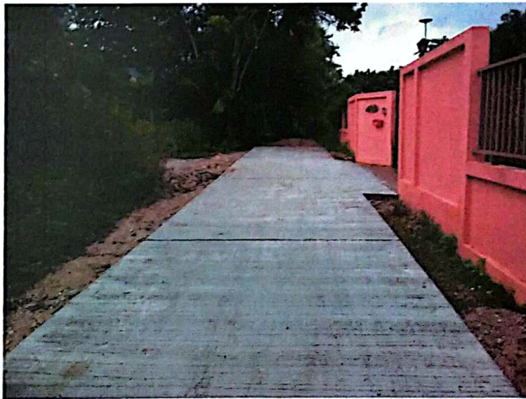
ก่อสร้างถนน ค.ส.ล. หมู่ที่ ๑๒ ซอย ๙
