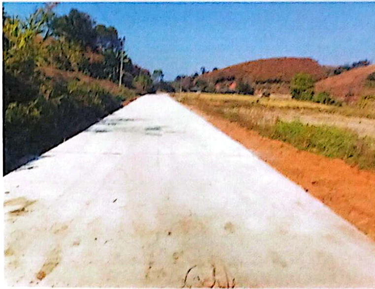
ก่อสร้างถนน ค.ส.ล หมู่ที่ ๑๐ ทางไปฟาร์มหมู
