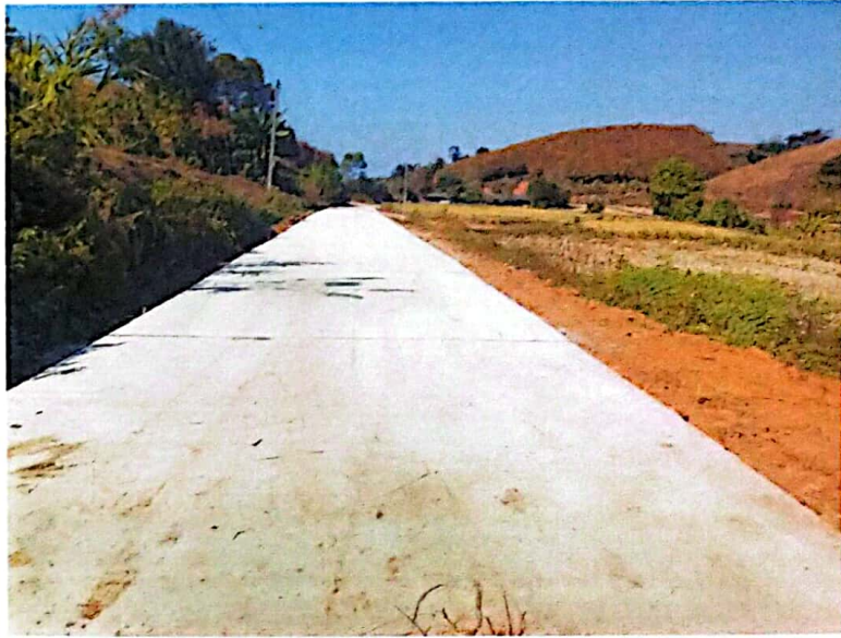
ก่อสร้างถนน ค.ส.ล หมู่ที่ ๑๐ ทางไปฟาร์มหมู
