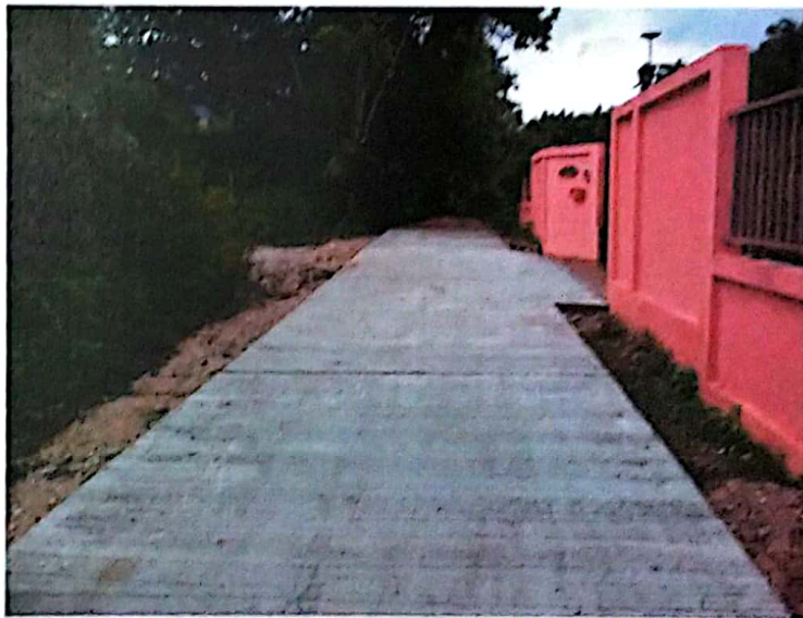
ก่อสร้างถนน ค.ส.ล. หมู่ที่ ๑๒ ซอย ๔
